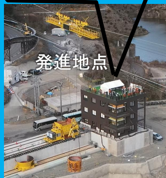
クレーン監視棟
