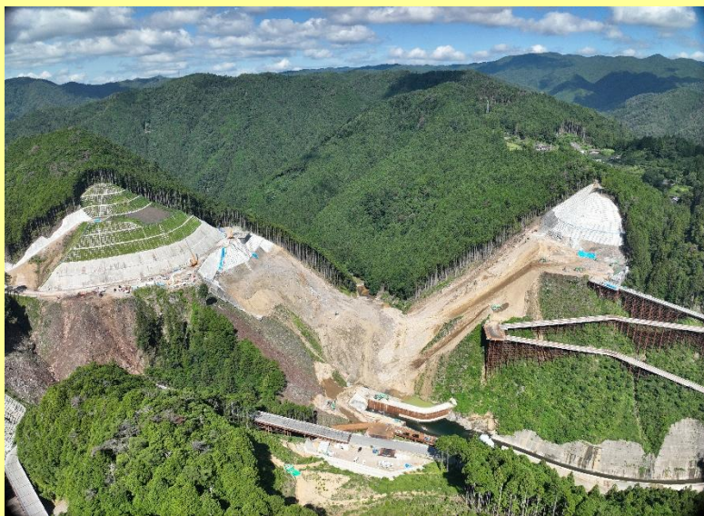
ダム本体(上流部より) (R7.6)
