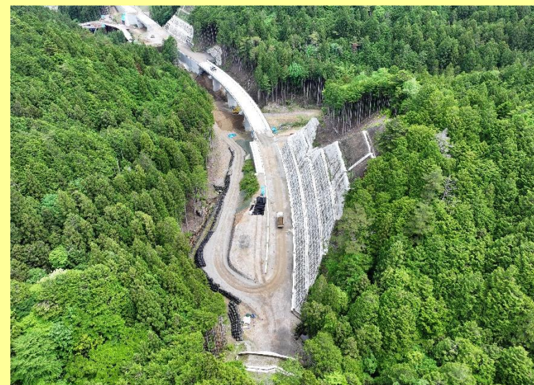
設楽根羽線1号トンネル～4号橋 (R7.6)
