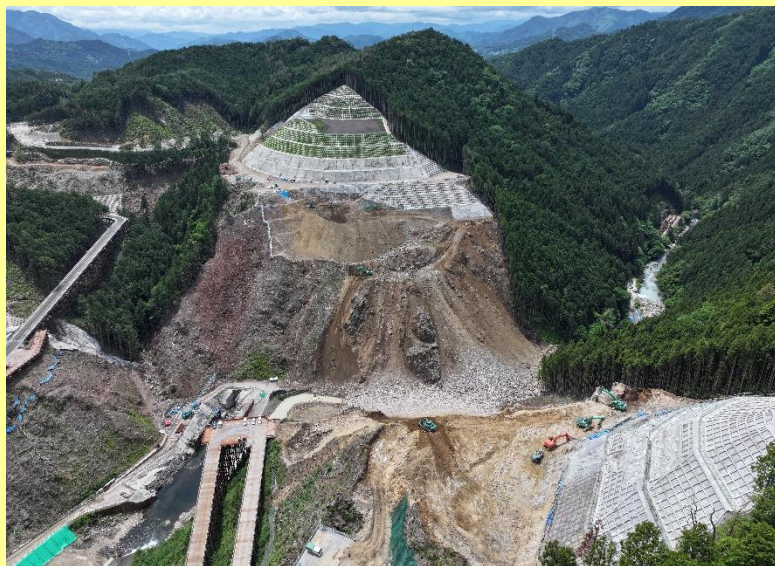
ダム本体(右岸頂部より) (R7.6)
