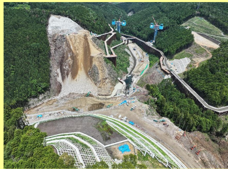
ダム本体(左岸頂部より) (R7.6)
