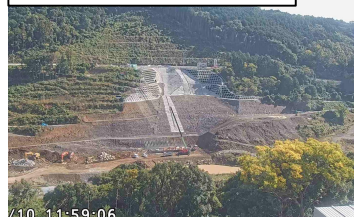
左岸基礎掘削状況_R7.11
