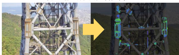
＜AI劣化診断例(発錆部抽出)＞
