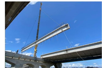
P C橋架設工
