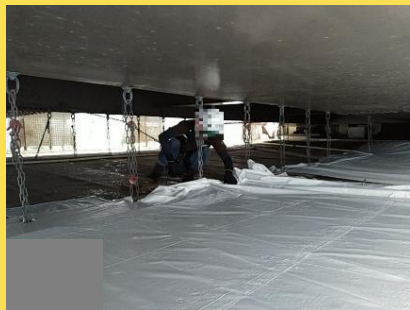
橋梁補修工 （塗装塗替足場工）
