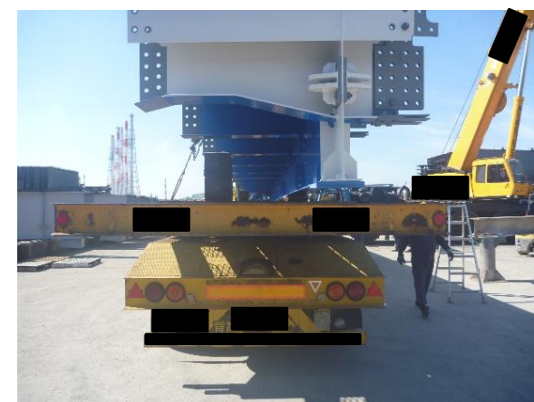
鋼床板鈑桁輸送状況
