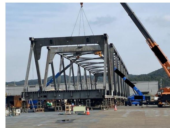
トラス仮組立状況
