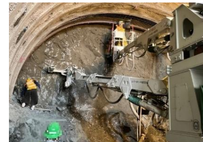
トンネル工（NATM）〔発破工法〕
