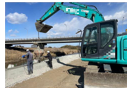
笠コンクリートブロック据付工
