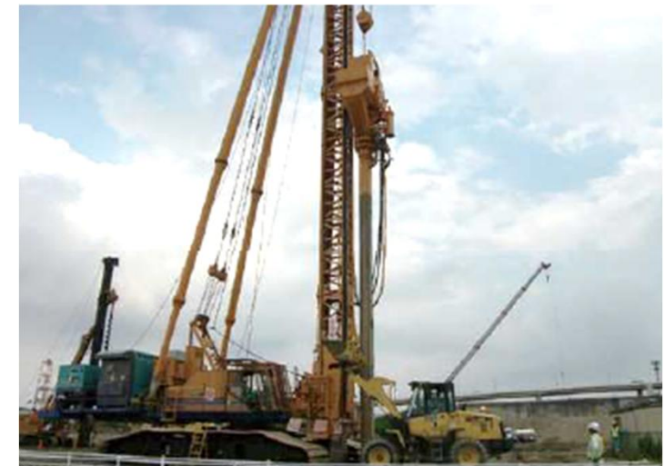
軟弱地盤処理工
