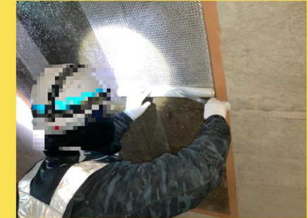
トンネル補修工 剥落防止対策工 （可視繊維シート接着工法）
