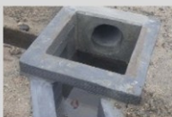
集水溝と側溝の一体型
