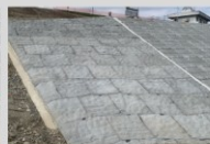
護岸ブロック
