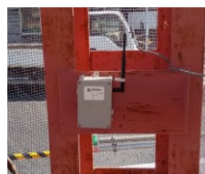
橋脚の安全管理
