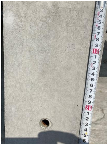
写真 5-4-3 表面気泡の補修事例(鉛直部)
