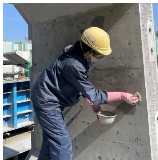
写真 8-4 補修状況(気泡)
