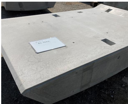
写真 5-3-1 ペースト漏れ
