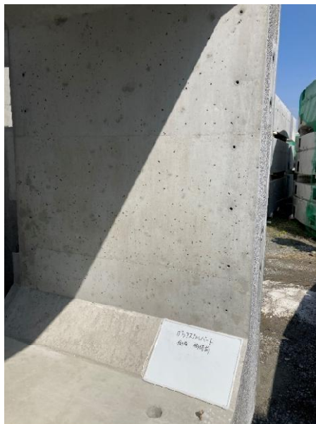
写真 5-4-1 表面気泡(鉛直面)の事例
