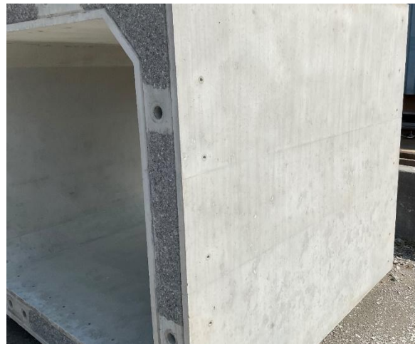
写真 5-4-4 表面気泡の補修事例(鉛直部)
