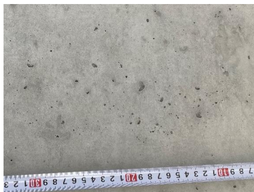
写真 5-4-2 表面気泡(鉛直面)の事例
