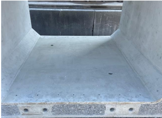
写真 5-4-8 表面気泡の補修事例(水平部)
