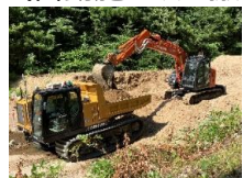
自動施工の高度化
