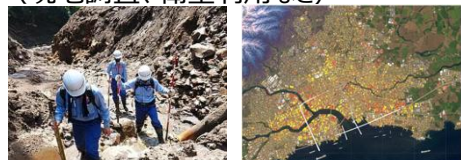
現地調査 被災状況把握
