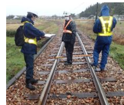
人力による 軌道管理の様子
