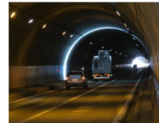
画像計測状況
