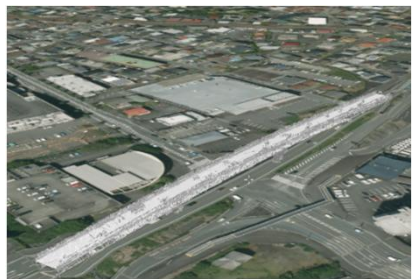
【工事完成後の点群データ】
