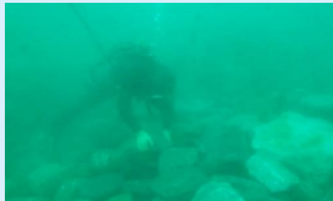
潜水作業（捨石均し）
