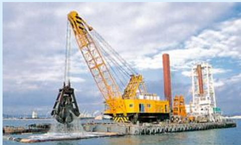
作業船（浚渫船）
