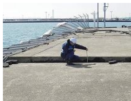
津波警報解除後の 現地調査（陸上）
