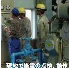
現地で施設の点検、操作
