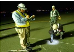
<ひび割れ計測>
