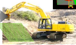
3次元設計データに沿って施工
