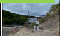
現場カメラによる遠隔監視
