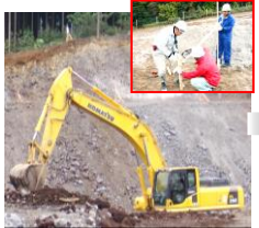
丁張りを目印に施工
