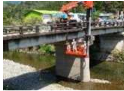
インフラの維持管理(点検作業)
