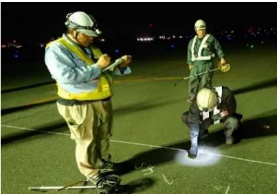
<ひび割れ計測>
