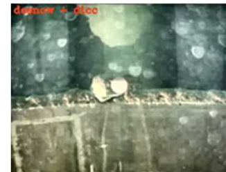
コンクリート構造物
