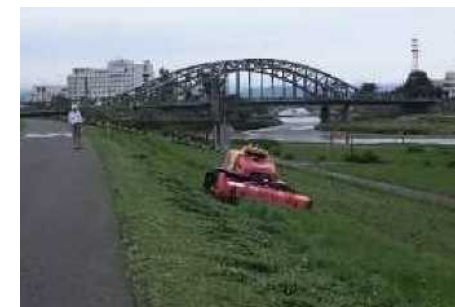
堤防除草作業の自動化
