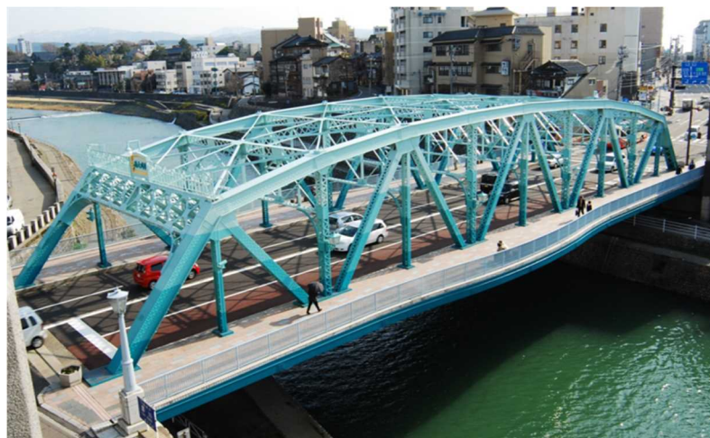
図 7-3-1 国道 157 号犀川大橋
