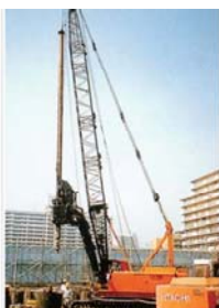
場所打ちコンクリート杭
