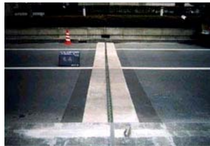
図-1 伸縮装置の目視検査
