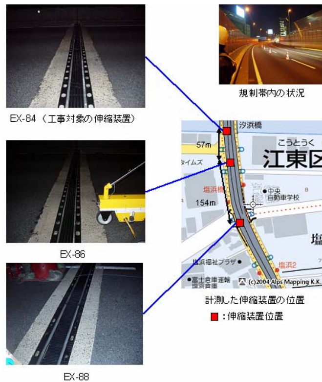
図 4-42 形状を計測した伸縮装置の位置と状況
