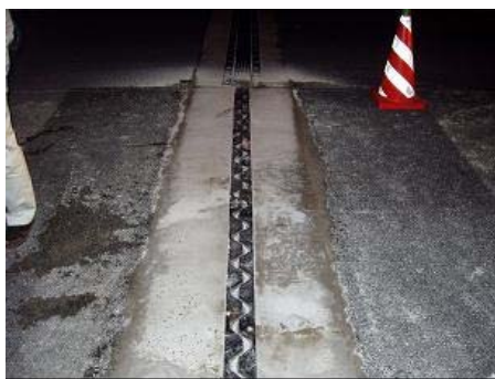
図 4-43 EX-84 工事後伸縮装置
