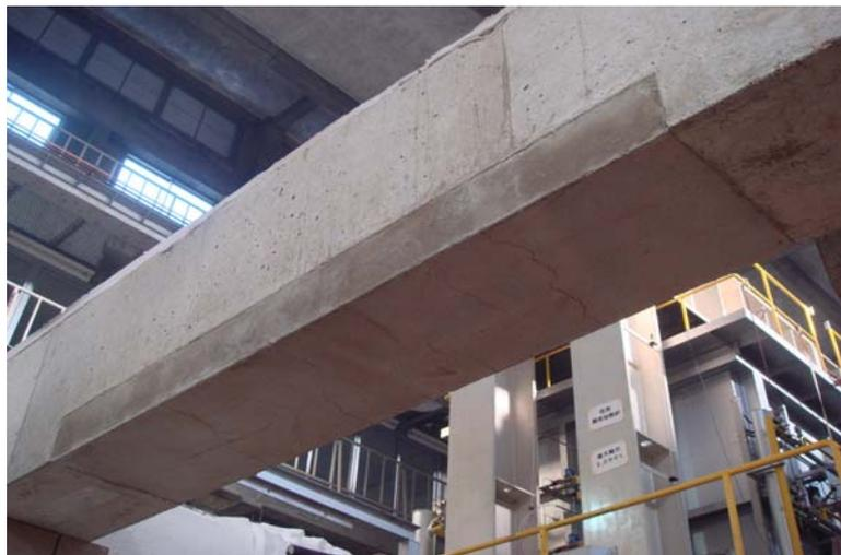
図17 補修部分のひび割れ
