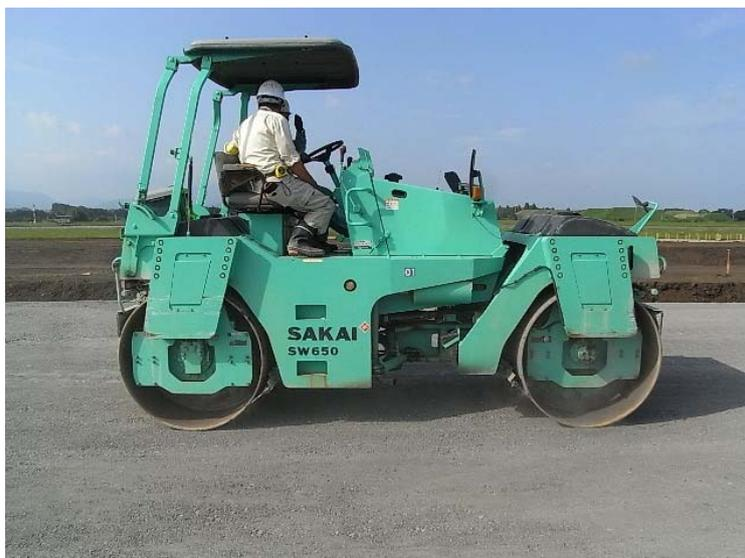
写真-5. 2 路床置換工  $\alpha$ 測定状況
