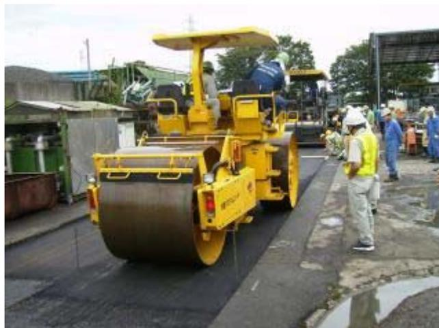
写真-7.1 MW700 での転圧状況
