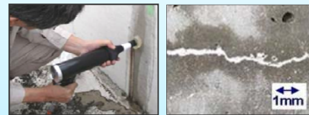
ひび割れ充填材の注入
