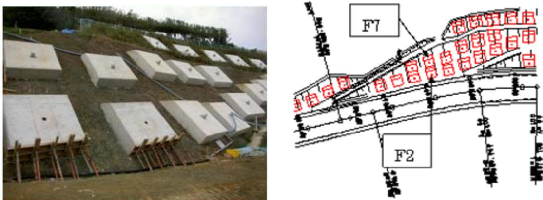
図7.2.5.1 アンカーの施工状況
