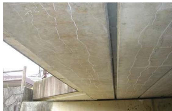
写真-7.1.2 PC 枠下面に生じた軸方向のひび割れ
