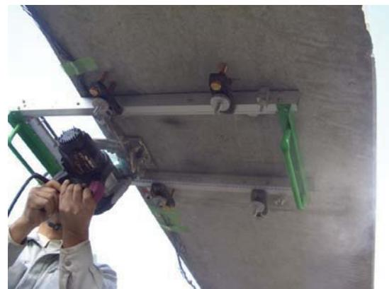
写真-5.4.3 スリット切削状況
