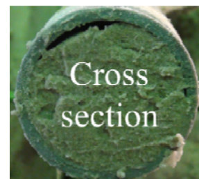
図 3-5-6 完全に閉塞した管内 (シース管を有しない場合)
