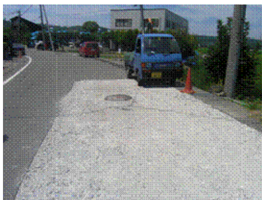
図２－１ 埋め戻し部のセメント固化改良による液状化の発生防止 （2007年新潟中越沖地震）
