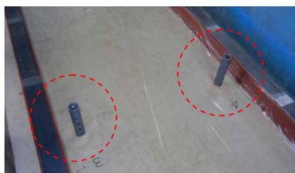
図 3.2.7 排水パイプ（上図）とその設置状態（下図）
