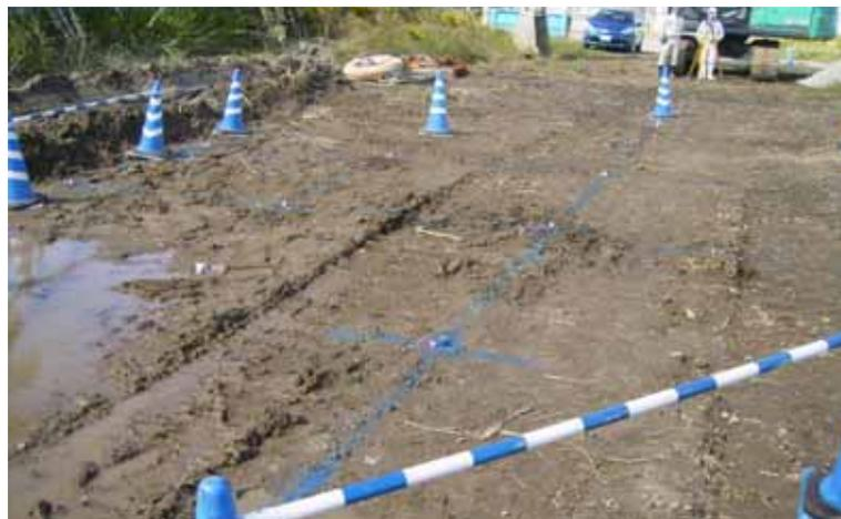
写真 19 地表面変状(水平施工 1)
