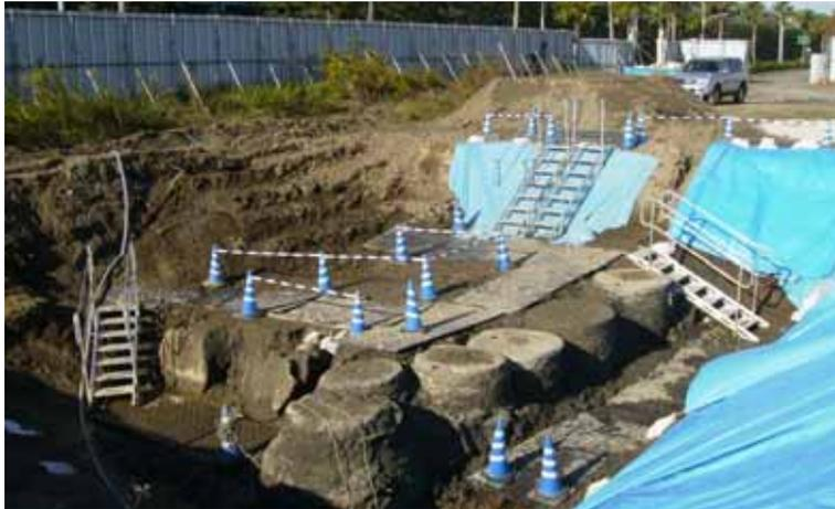
写真 21 施工後の観察のために掘削した状況
