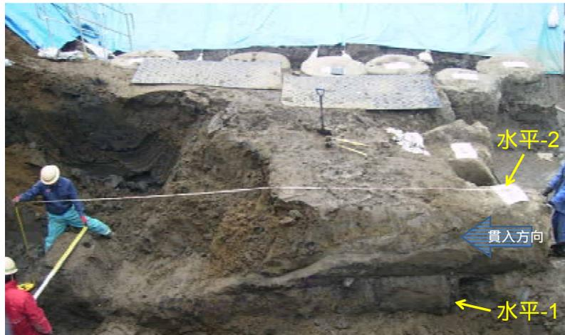
写真 28 改良状況(水平施工の掘りおこし状況)
