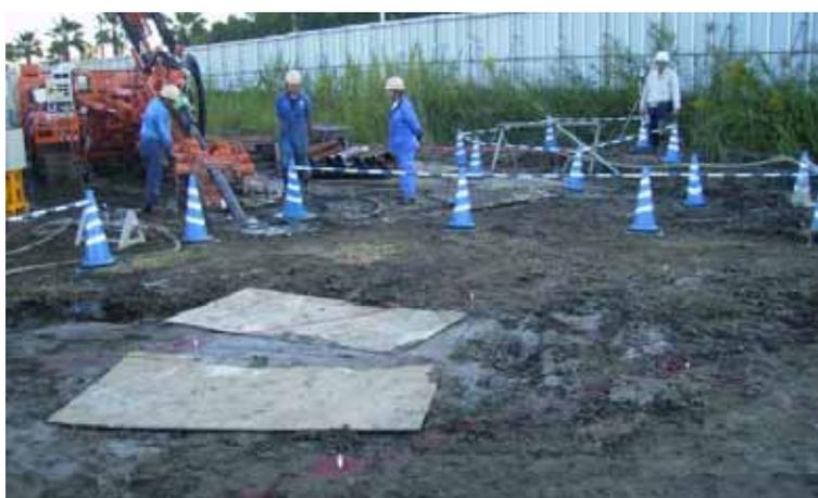
写真 17 地表面変状(斜め施工)
