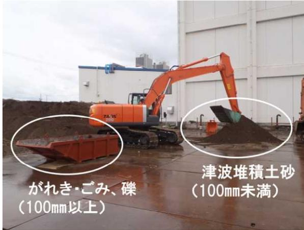
写真-3.8 スケルトンバケットによる分別状況
