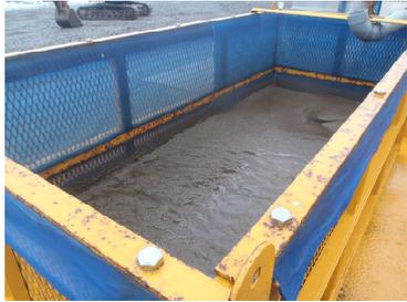
脱水ボックスによる簡易脱水
