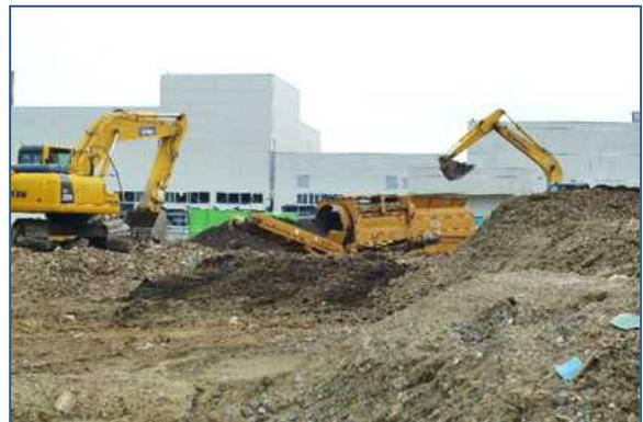
写真-2.3 トロンメル（回転式ふるい）と津波堆積物の分別状況
