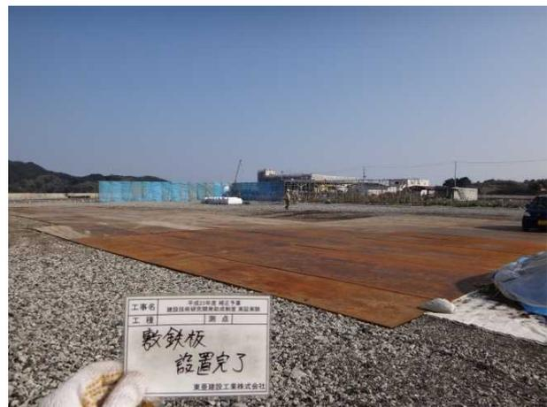
写真-3.7 重機作業範囲の敷鉄板敷設
