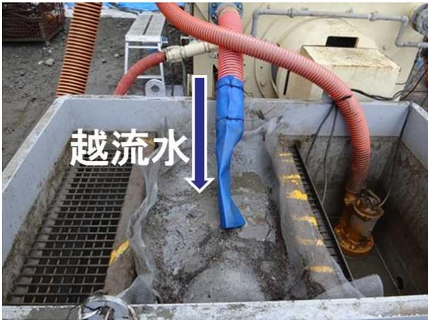
写真-3.22 浮遊ごみの回収（回収タンク）
