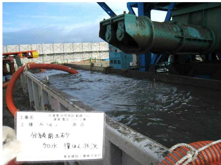
写真-2.10 加水・攪拌状況（実績 2；70m<sup>3</sup>/hr 級）
