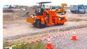
再生砕石による基礎盛土の施工
