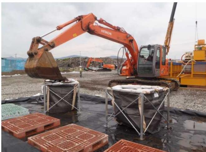
写真-3.35 水切りフレコンによる脱水
