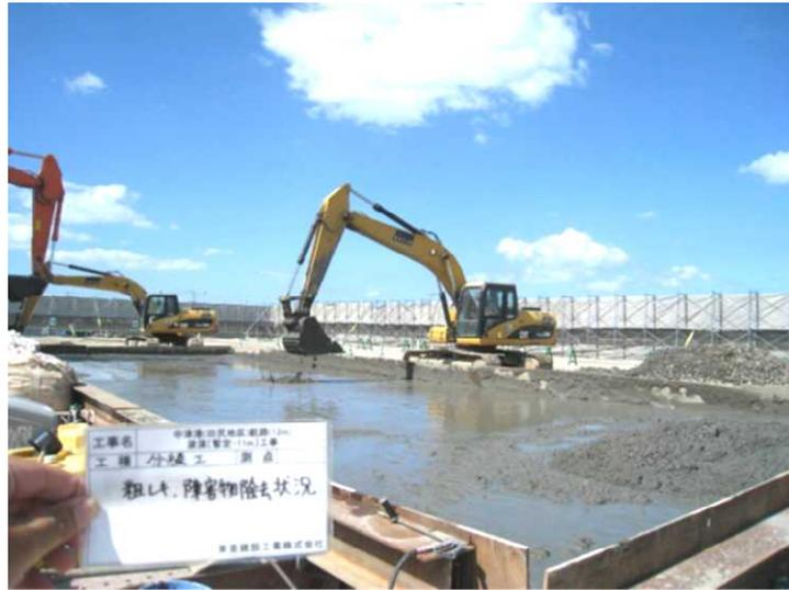
写真-3.17 湿式分級における1次処理（ピット内で加水）の例
