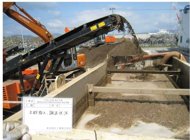
写真-3.19 攪拌槽への土砂の投入状況
