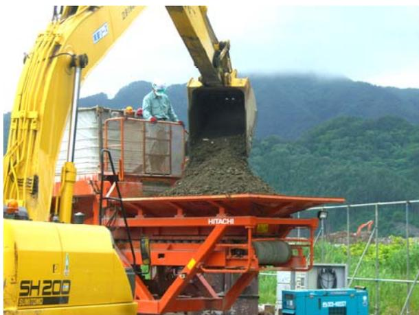
写真-58 材料投入（骨材）
