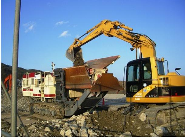
写真-7 破砕機へのがれき投入状況
