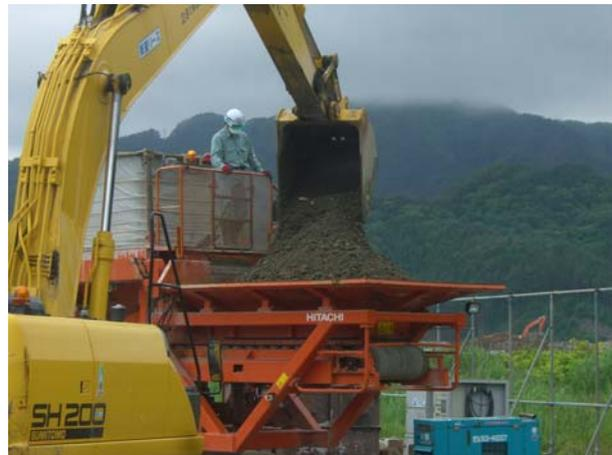
写真-17 コンクリートがれきの供給状況
