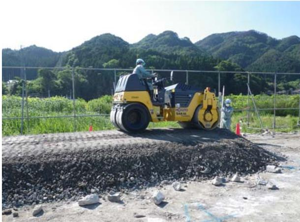
写真-64 振動ローラー転圧状況
