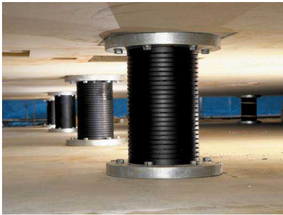
写真 1.2 軽量構造物に適用可能な免震構造用積層ゴム支承の実用化
