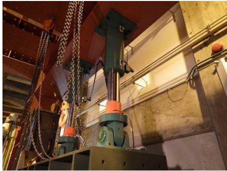
鉛直方向油圧ジャッキ+ロードセル
