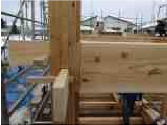
写真 2.3.8 鼻柱・込柱を打つ
