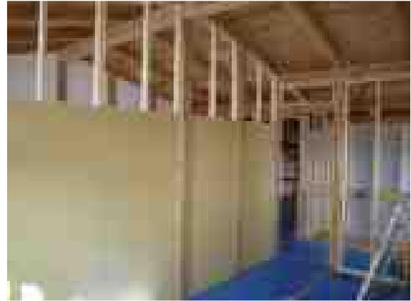
写真 2.3.22 内部間仕切工事
