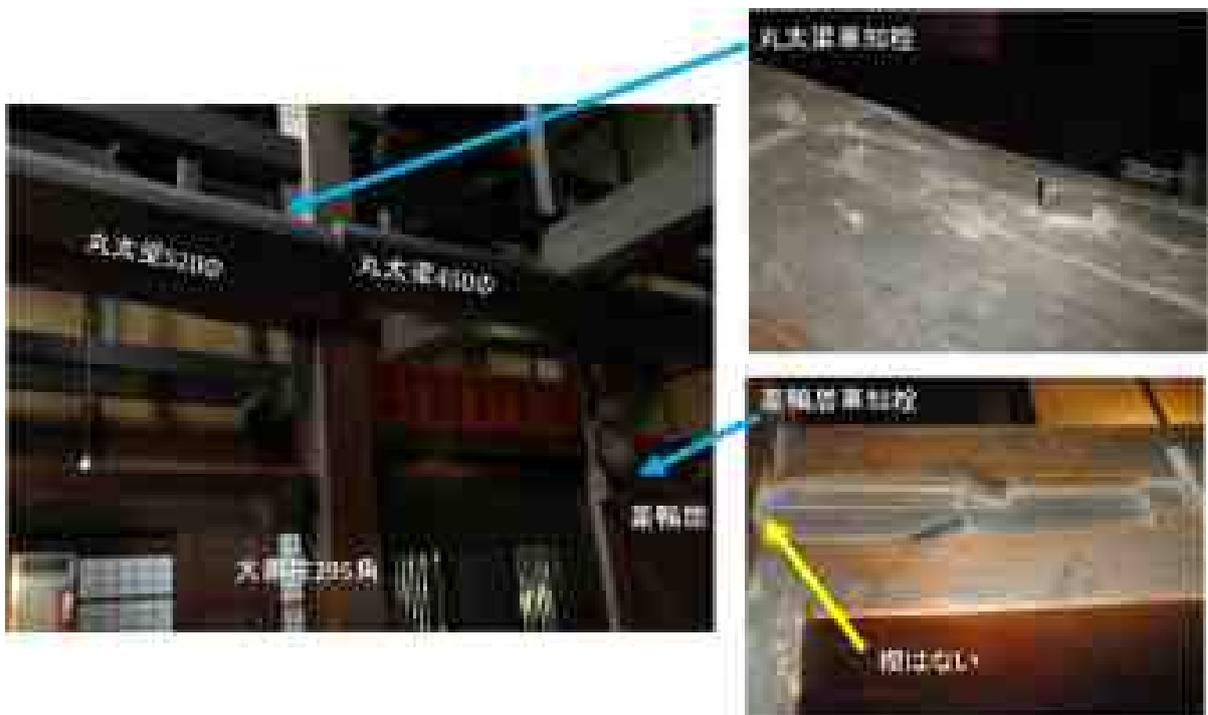
写真 2.3.25 丸太梁と差鴨居の車知栓打ち仕口 (吉島家)
