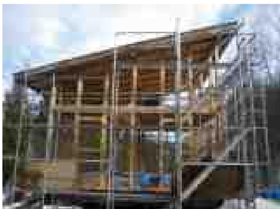
写真 2.3.1 壁パネル取り外し後
