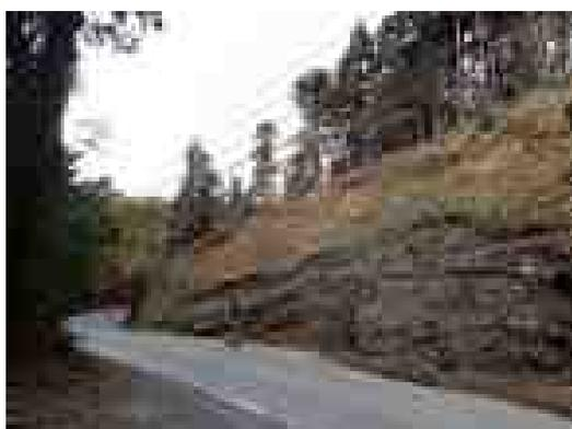
写真 3-31 切土斜面の崩壊
