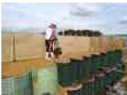
写真 10-1 プレートランマーによる盛土転圧
