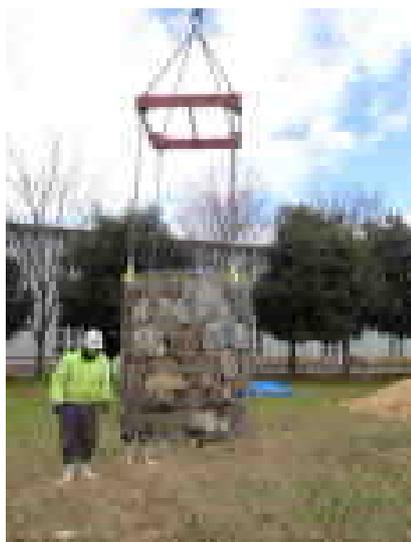
写真 8-7 円筒金網の鉄線径 φ 6 mm
