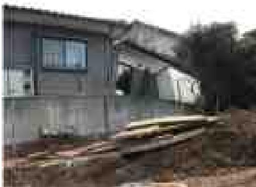
写真 3-18 地すべりによる宅地の隆起<sup>6)</sup>
