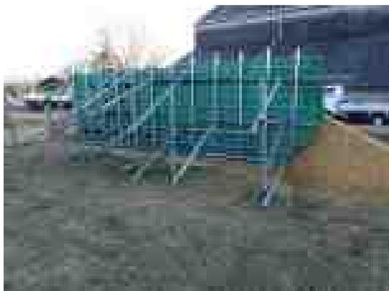
写真 10-5 試験用盛土完了（引抜き側）
