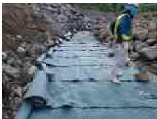
写真 13-8 吸出し防止材設置
