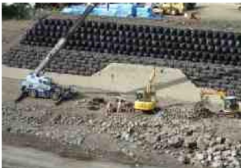
写真 3-116 作業ヤードでの袋詰め栗石製作の様子
