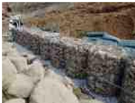
写真 13-13 大型円筒金網据付け
