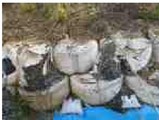
写真 3-25 大型土のうの劣化, 崩れ
