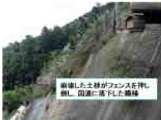
写真 3-124 押し倒されたフェンス
