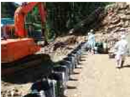
写真 3-65 円筒金網設置状況
