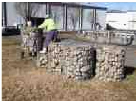
写真 9-5 円筒金網の据付け状況
