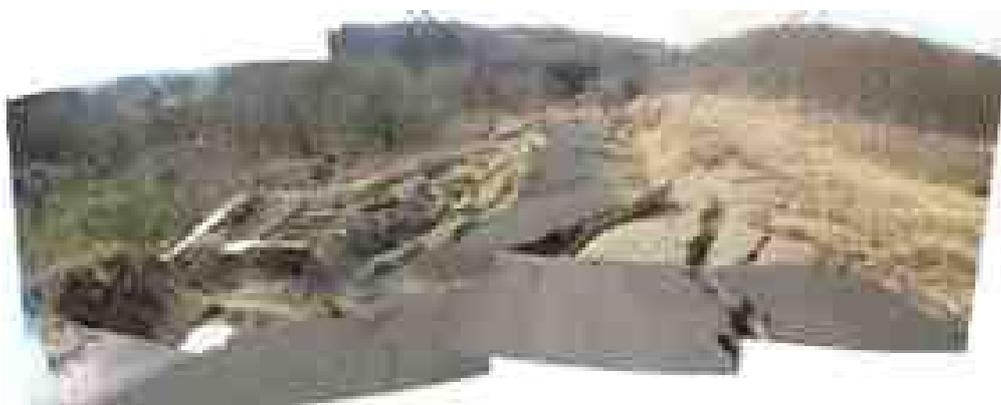
写真 3-70 災害時法面崩壊中間部の状況<sup>11)</sup>
