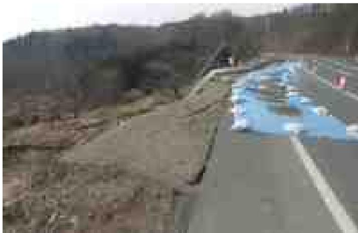
写真 3-69 災害時道路路肩の崩壊（すべり頭部）<sup>11)</sup>
