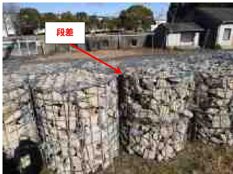
写真 9-9 円筒金網ハーフサイズ部分の段差
