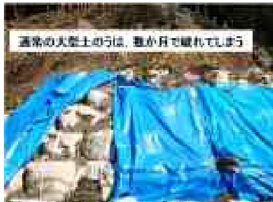
写真 3-118 大型土のうの崩壊
