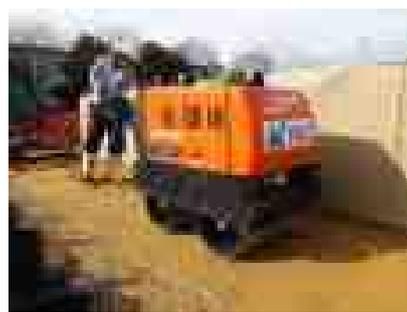
写真 10-2 ハンドガイド振動ローラによる盛土転圧
