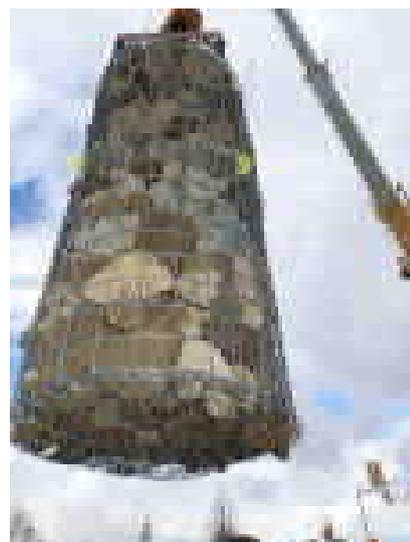
写真 8-10 円筒金網の鉄線径 φ 6 mm
