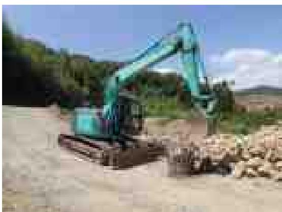
写真 13-5 バックホウによる栗石中詰め
