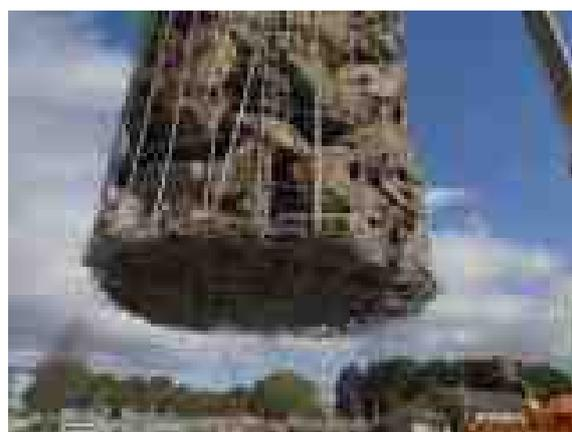
写真 8-6 円筒金網の鉄線径 φ 5 mm
