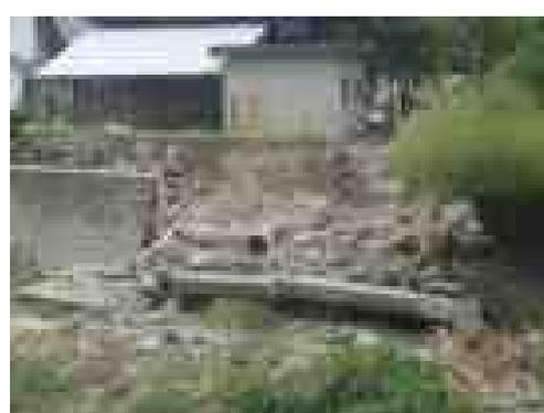
写真 3-149 コンクリートブロック積護岸の崩壊
