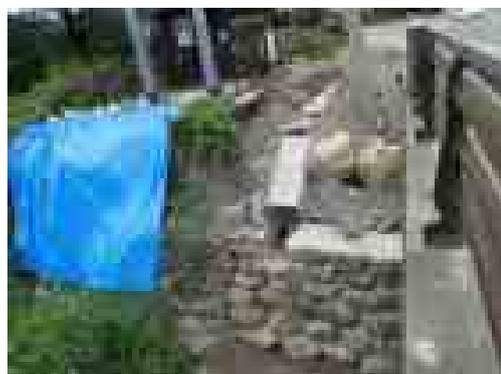
写真 3-148 練石積護岸の崩壊
