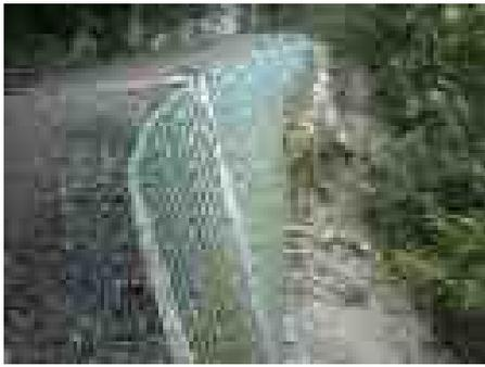
写真 1-1 チェーンウォール工法の概観
