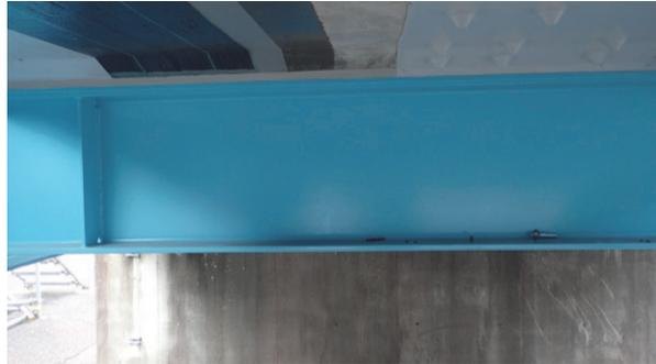
図-5.2 横桁の垂直補剛材と一般部
