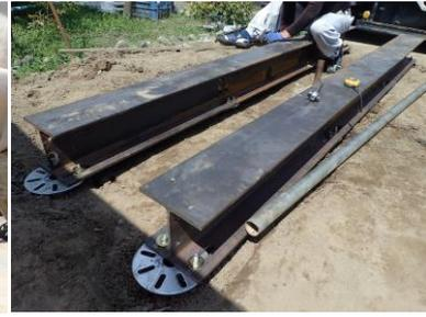
写真 4.3 架台設置 200H型鋼
