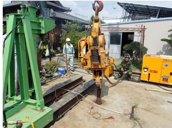
写真 4.7 バイブロによる起振状況（H 型鋼部分改良）
