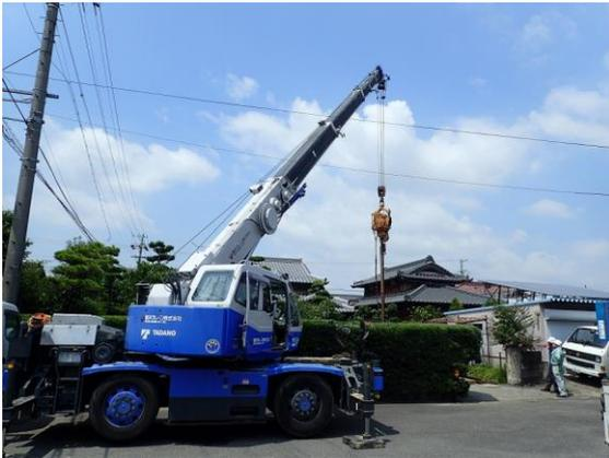
写真 4.6 10t ラフタークレーンによる H 型鋼打設状況
