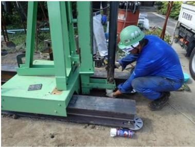
写真 4.4 鉛直ドレーン施工
