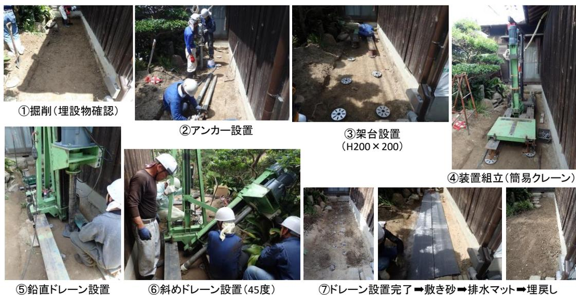
図 4.8 ドレーン敷設の作業手順と施工状況
