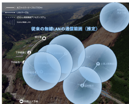
阿蘇大橋地区での工事用AP設置位置
