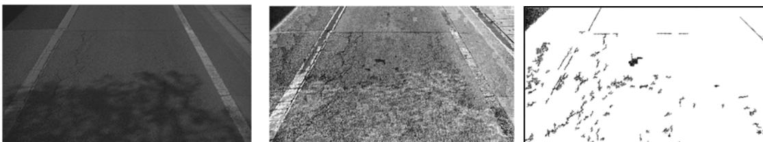
図 1.4 路面の原画像、輝度補正後の画像、クラック抽出フィルタを適用した画像の例
