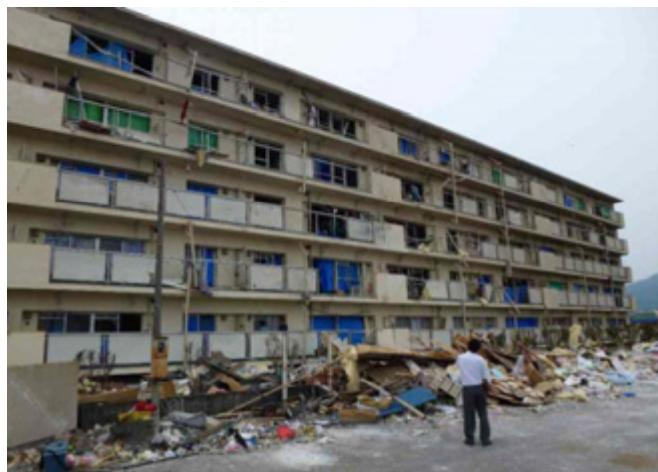
RC造建築物の非構造材被害
