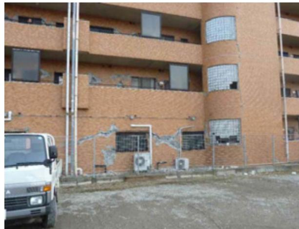
RC造建築物の非構造壁損傷
