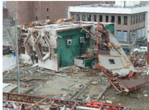
外装材が流失せず転倒した事例
