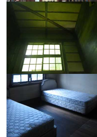
外観は趣を維持しつつ内部を防火的に改修(安全性を確保する代替手法の開発)
