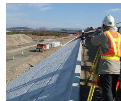
出来形管理状況(護岸工)
