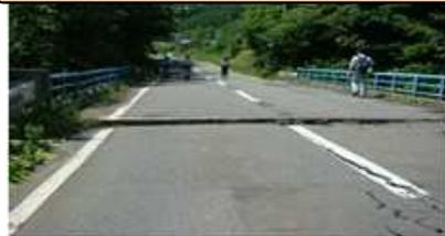
桁端部での損傷による段差発生が最多
