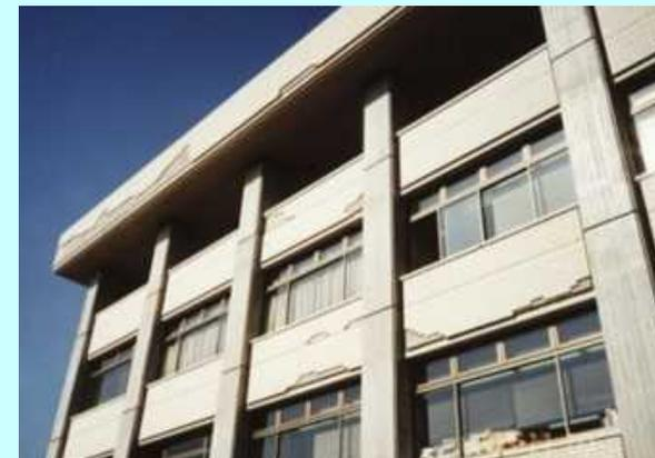
従来の外壁面部材の打診検査には、足場の設置が必要で、検査コスト高く検査実施率・頻度が低かった。
