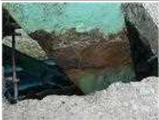
鋼トラス部材の埋め込み部の破断
