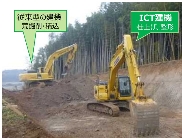
現地状況等に応じて、ICTと従来の建機を使用
