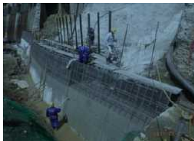
擁壁工 外壁の埋設型枠
