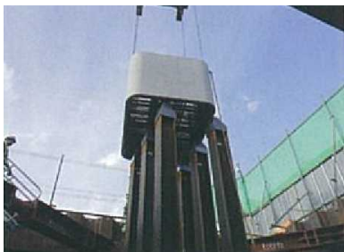
橋梁下部工 橋脚部の埋設型枠
