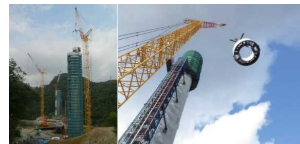
クレーンで吊り込み設置
