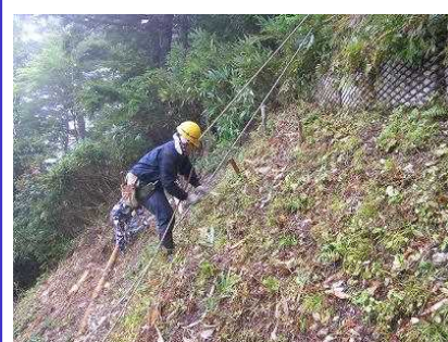
斜面上の測量作業
