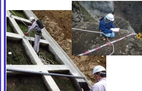
高所斜面上の臨場検査
