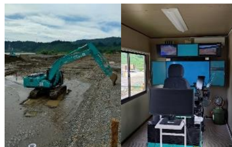
北陸地方整備局 しおどの 塩殿遊水地整備その4工事 （新潟県）
