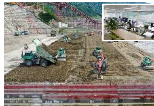
東北地方整備局 なるせ 成瀬ダム堤体工事 （秋田県）
