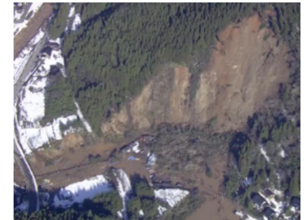
⑭能登半島地震 (石川県輪島市) TEC-FORCE撮影
