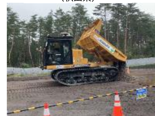
関東地方整備局 じぞう 地蔵川第一砂防堰堤工事 （長野県）
