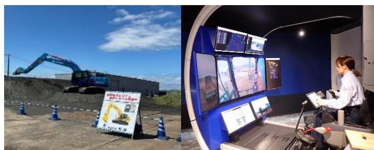
北陸地方整備局 おおこおづ 大河津分水路山地部掘削その2 3 他工事 （新潟県）
