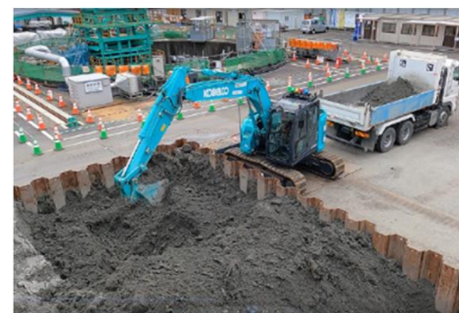
関東地方整備局 かすみがうら いしおか 霞ヶ浦導水石岡トンネル 新設工事 （茨城県）
