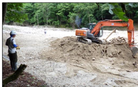
中部地方整備局 じごくだに 地獄谷第4砂防堰堤工事 （岐阜県）
