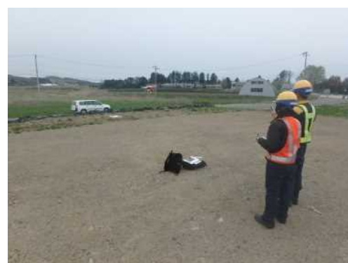
↑ UAV測定の検証を行い現場での実効性を確認
