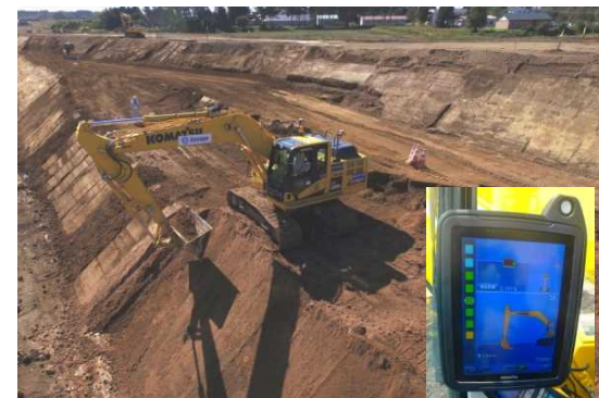
↓ MCバックホウによる盛土法面整形
