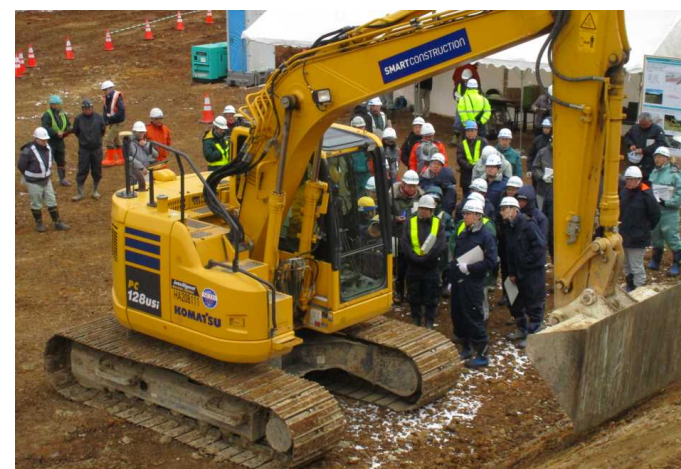
I C T 建設機械の説明
