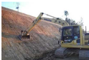
＜MGバックホウ(TS仕様) による法面整形＞
