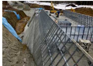
左 橋脚部埋設型枠 右 擁壁工の 外壁部埋設型枠
