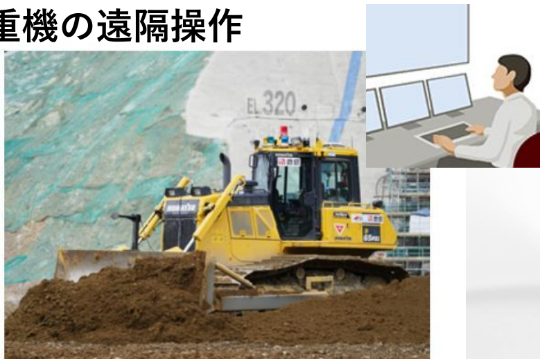
自動ブルドーザによるまき出し状況
