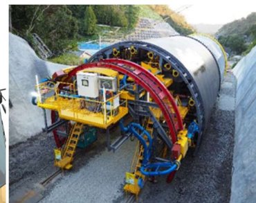
覆工自動打設ロボット 省人化 (6→2名)
