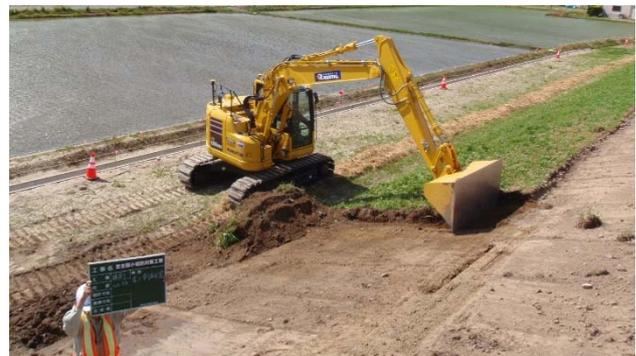
写真-1 ICT バックホウによる表土掘削
