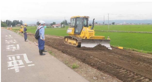
写真-3 ICTブルドーザによるまき出し状況
