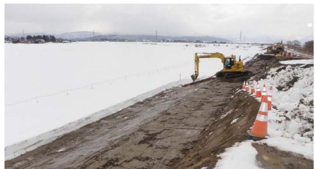
写真-8 ICT建機による除雪状況
