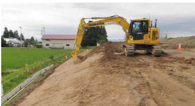
写真-4 ICTバックホウによる法面整形状況
