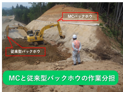
写真-4 MCバックホウの作業分担
